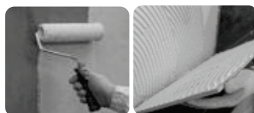
Acabados del sistema
