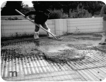
Cubierta plana transitable
