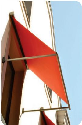
En caso de decidir colocar un **sistema de protección solar tipo toldo** convencional o extensible, se debemos tener en cuenta que al situarlo en la fachada, debemos colocarlo fuera del hueco de la ventana, para así poder separarlo una determinada distancia de la fachada, para permitir que el aire caliente que asciende por ésta pueda salir y no se formen bolsas de aire caliente bajo el propio toldo.
