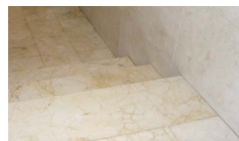
Peldaños sin señalización (riesgo de caída)
